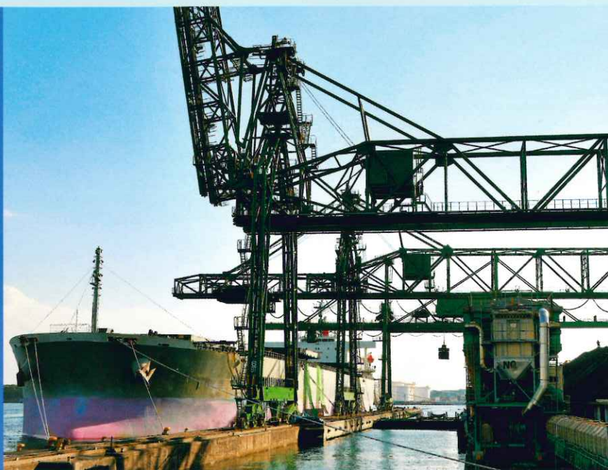
川崎支店 平成20年10月稼働 新大型荷役機械
