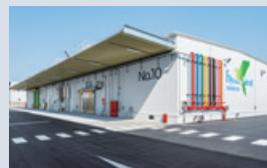
今回導入した中温化アスファルト舗装材は、アスファルトの粘度を一時的に低下させる技術を用いて、製造・施工時の温度を10℃程度低減できるアスファルト混合物であり、従来の方法に比べ538kgのCO<sub>2</sub>排出量の削減を実現しております。
